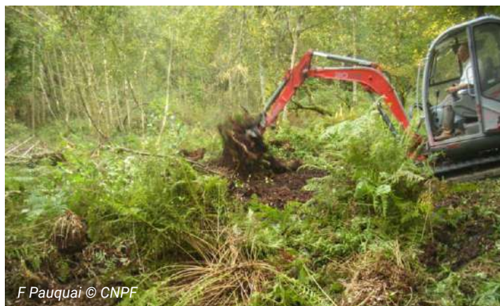
Réalisation de potets travaillés à la pelle mécanique, en vu d'un enrichissement.
