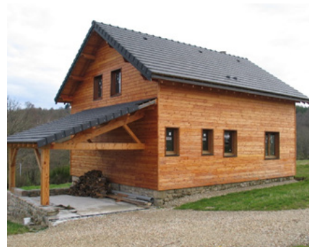
4- Maison à ossature bois, structure et bardage en douglas
